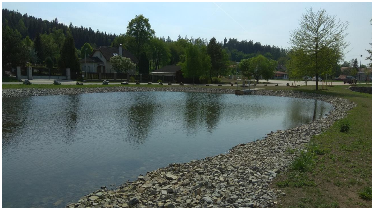
Obrázek 18: opevnění břehů navrženým způsobem krátce po realizaci typově stejného opatření
