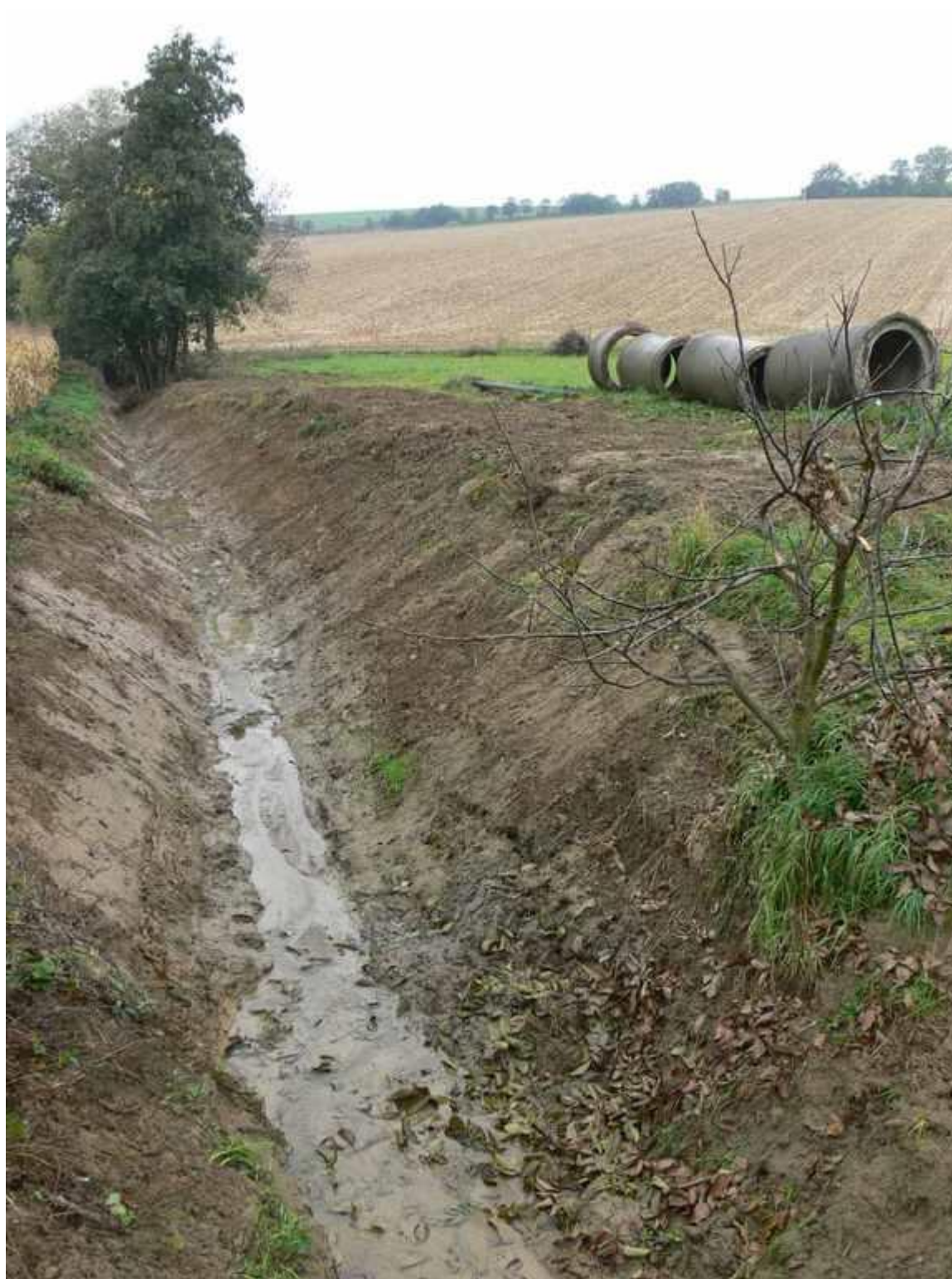
Obrázek 10: čerstvě zrušené zatrubnění toku
