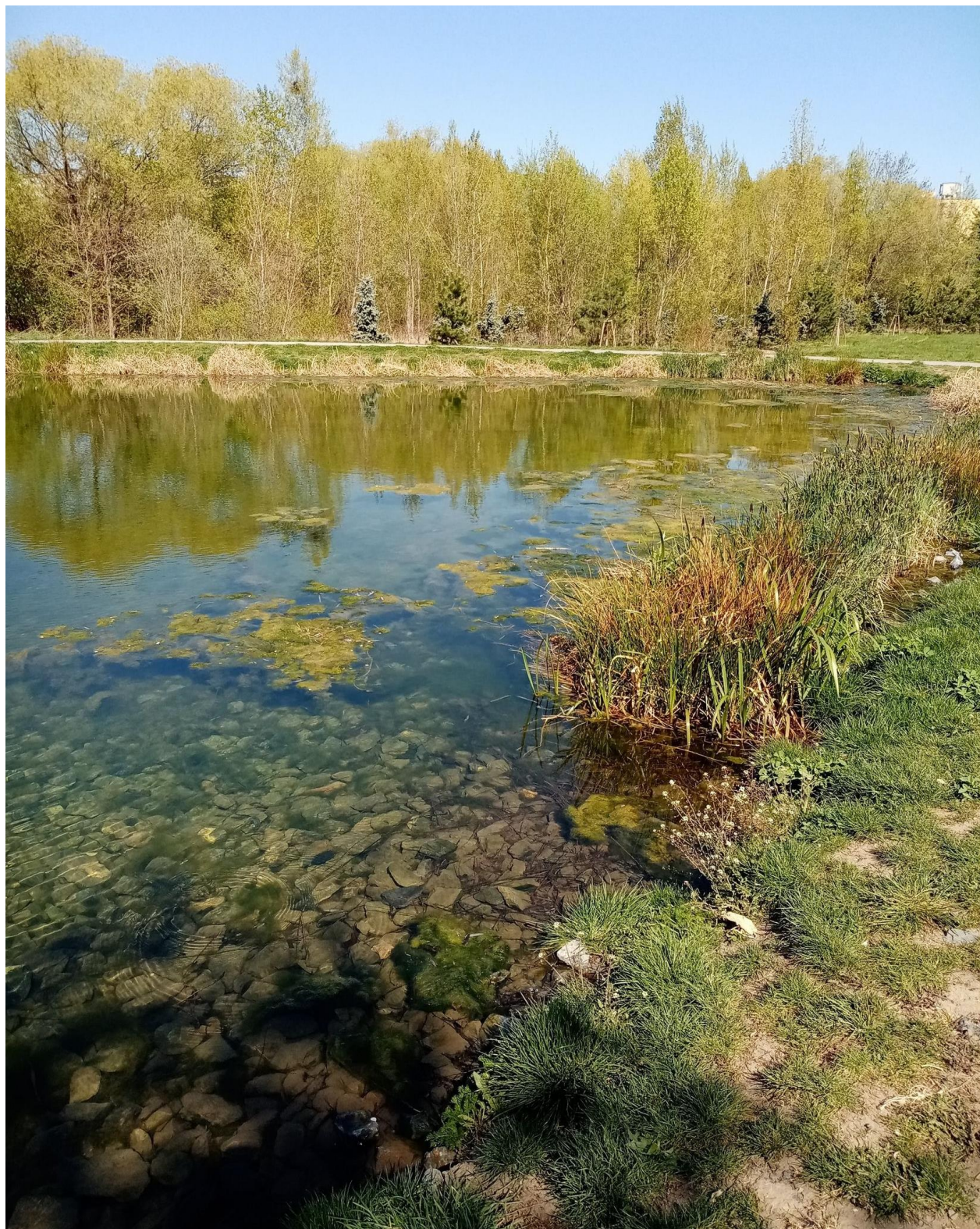
Obrázek 19: opevnění břehů kamenným záhozem po zapojení porostů
