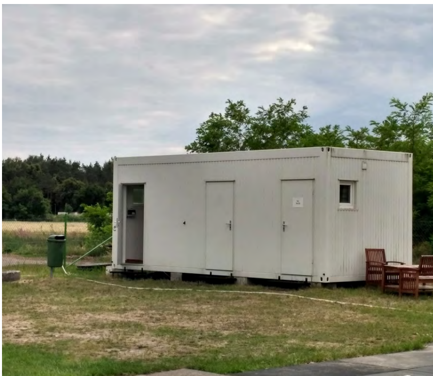
Obr. 2 / Zázemí hasičského cvičiště vybudované v roce 2011, pozemek p. č. 1482/2, v majetku Obce Písková Lhota, smlouva o dlouhodobém pronájmu
