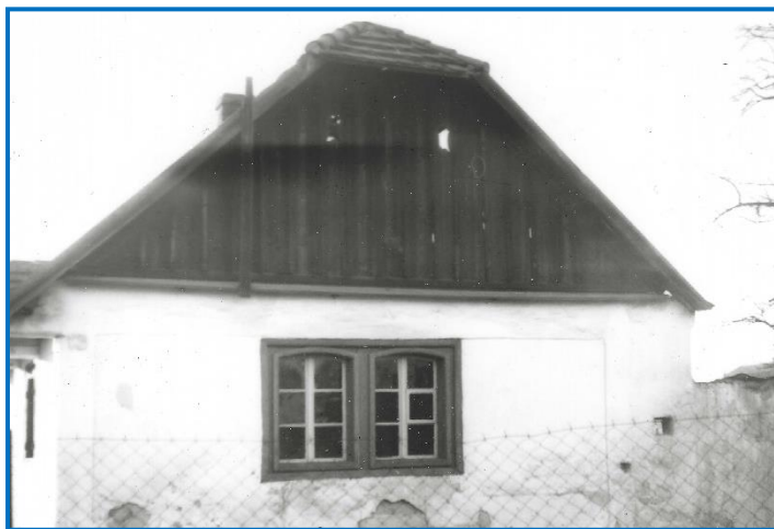
Dnes již historický snímek – dům č. P. 22 (bývalý statek) v objektu JZD byl demolován, aby ustoupil nové výstavbě JZD
