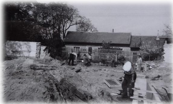
Šalování základů nového obchodu
