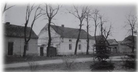
Dům č. 56 s výměnkem před demolicí. Místo budoucího obchodu
